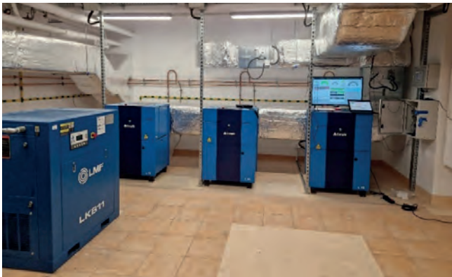
Rys. 3. Ekran lokalny przeznaczony dla personelu technicznego – stanowisko badawcze – stacja powietrza medycznego – szpital w województwie małopolskim Fig. 3. Local monitoring system intended for technical staff – research station of the medical air supply system - hospital in the Lesser Poland Voivodeship
